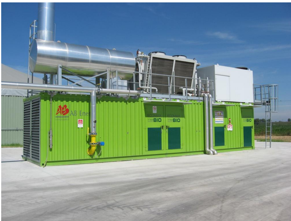
Tipica installazione di cogeneratore in container
