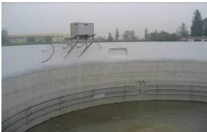
Anelli di riscaldamento ,fermentatore ancora aperto
